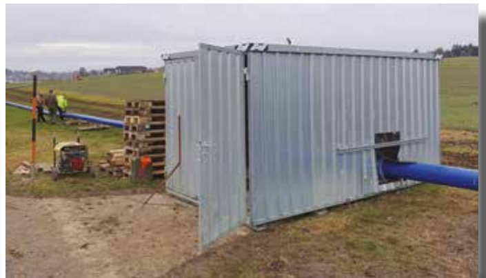
oben: Leitungsverlegung in Höhe Reiching links: Die Anschlussstelle in Rottmoos
