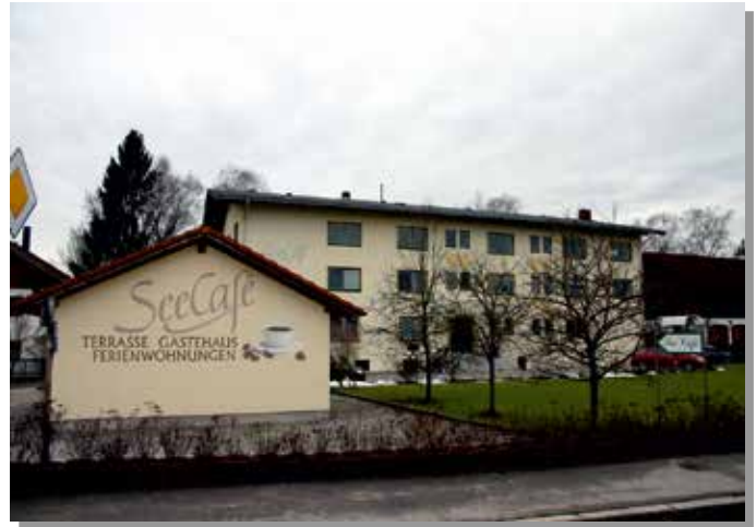
Das fertiggestellte Seecafe
