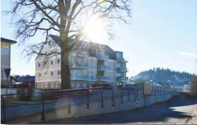
Das Geländer an der Stützmauer in der Seestraße wurde angebracht
