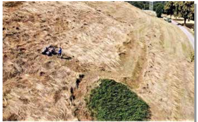
Der Steilhang in Teufelsbruck Richtung Staustufe
