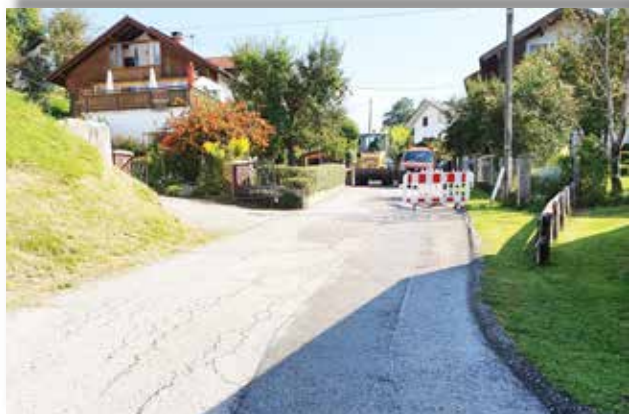
Im Bereich Marienberg steht eine Straßensanierung an
